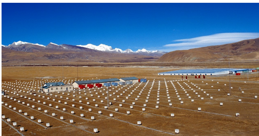
图3 西藏羊八井国际宇宙线观测站,图中白色的是中日合作AS- \gamma 阵列的探测器,蓝色屋顶的大厅内安装了中意合作ARGO地毯式探测器阵列
