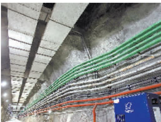
通往大亚湾中微子实验厅的隧道。
